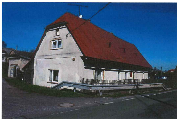
Celkový pohled ze silnice
