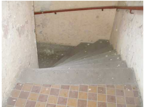
Schodiště do patra
