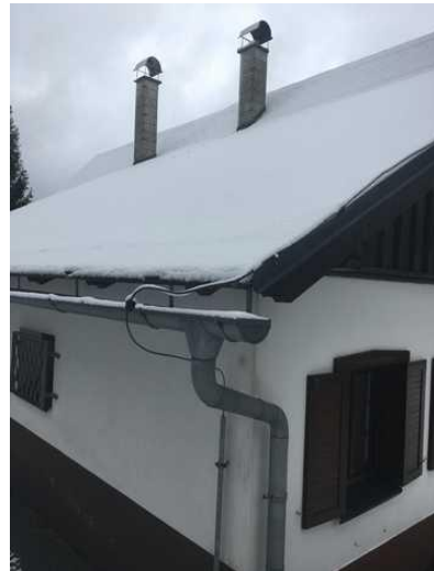
Pohled roh JZ
