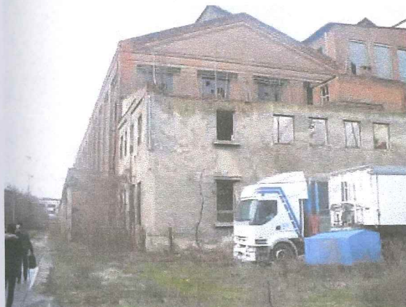
hlavní výrobní hala na pozemcích p.č.389,390 a 391 - k asanaci
