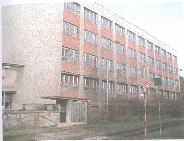
adm. budova na pozemku p.č.383/2 a p.č.402/9 -12
