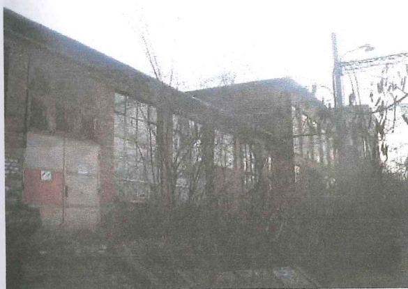
hala na pozemcích p.č.384 a p.č.402/13,14 - k asanaci
