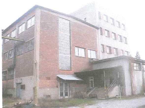
hala na pozemku p.č.383/1 a p.č.402/7,8 ( k asanaci)
