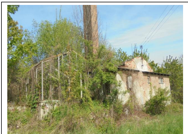
Nemovitá věc - pozemek p.č. 861, součástí je stavba č.p. 70 – zem. stav, pohled zvenčí č. 1
