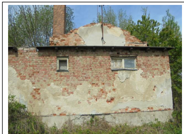
Nemovitá věc - pozemek p.č. 861, součástí je stavba č.p. 70 – zem. stav, pohled zvenčí č. 2
